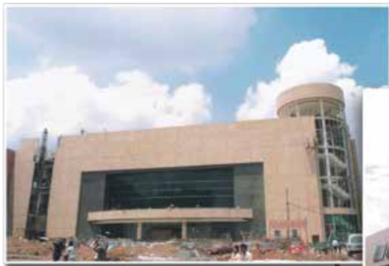
Obra en proceso
