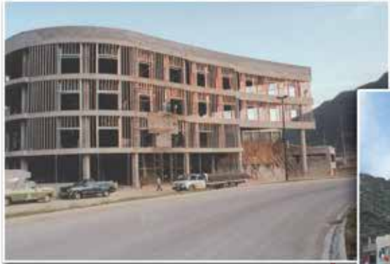
Obra en proceso
