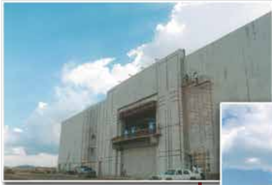
Obra en proceso
