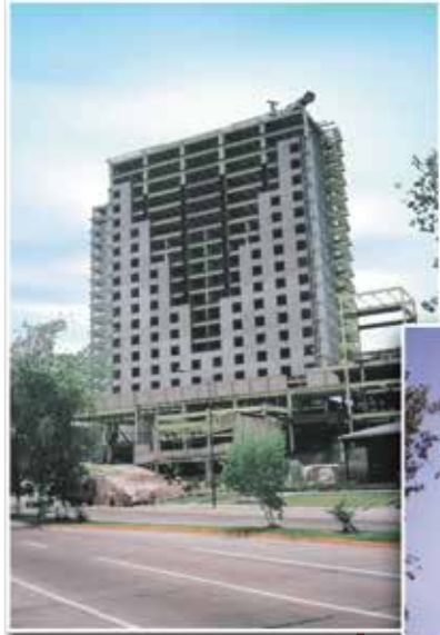
Obra en proceso
