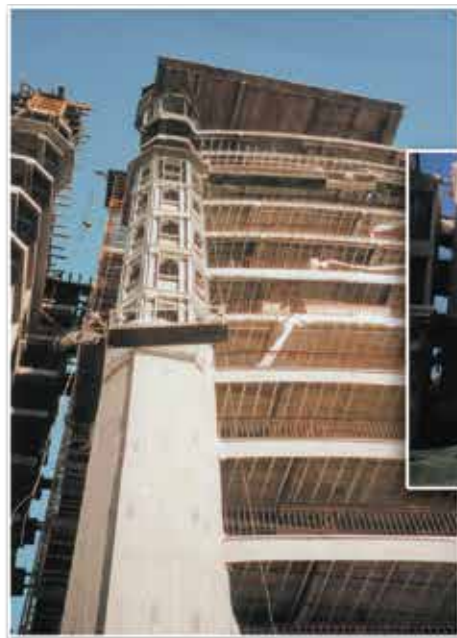
Obra en proceso
