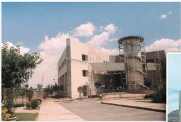
Obra en proceso
