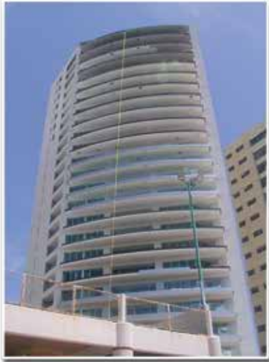
Obra en proceso
